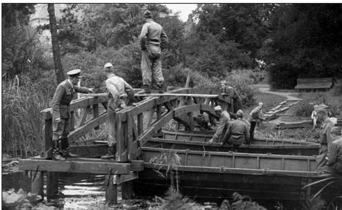
Budowa mostka na stawie, 1958 r.
